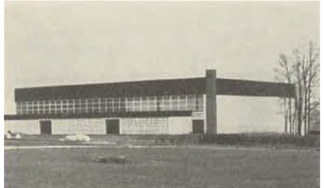
1971 - Gymnase Guy kappes © Archives Mairie Lagny-sur-Marne.
